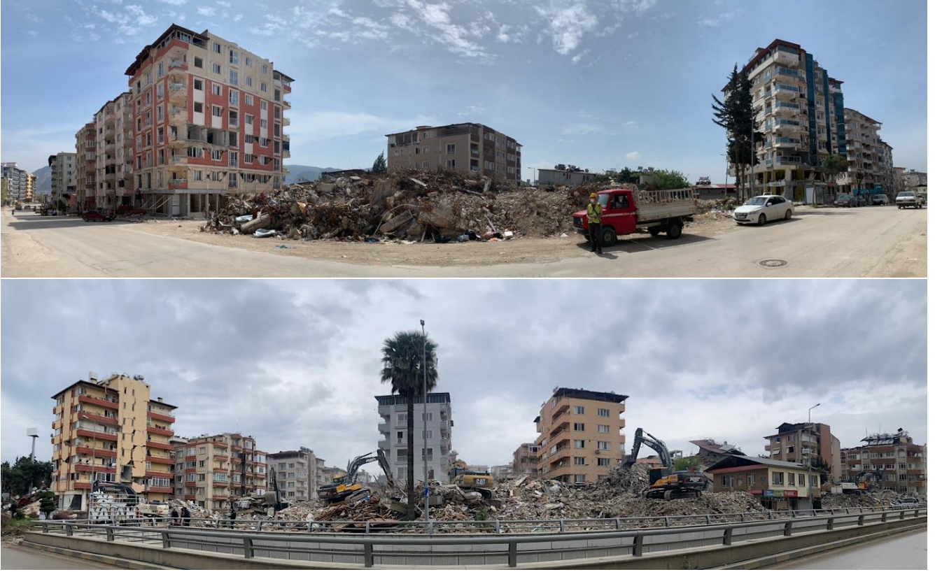
Şekil 67. Antakya tarihi kent merkezi dışındaki yapılaşma alanlarının deprem sonrası durumu
