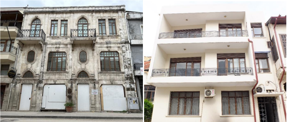
Şekil 46. Kurtuluş Caddesi üzerinde hasarsız geleneksel ve modern dönem yapı örnekleri
