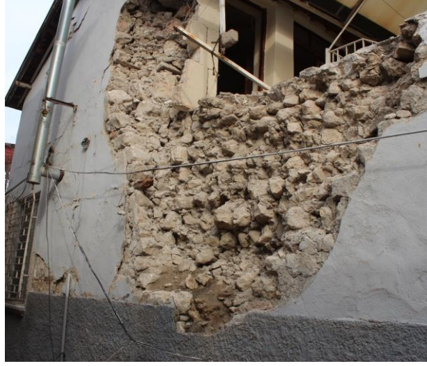
Şekil 56. Hatıl ve bağ kirişlerinin kullanılmadığı yığma taş duvar örgüsü (ODTÜ TAÇDAM, 2023)
