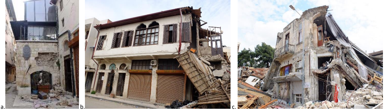
Şekil 51. a. minör yıkım / malzeme kaybı; b. kısmi yıkım; c. büyük oranda yıkım olan yapılara örnekler
