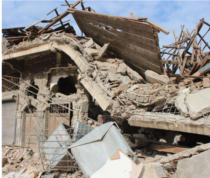
Şekil 64. Geleneksel yapıya eklenen betonarme döşemenin sebep olduğu yıkım (ODTÜ TAÇDAM, 2023)
