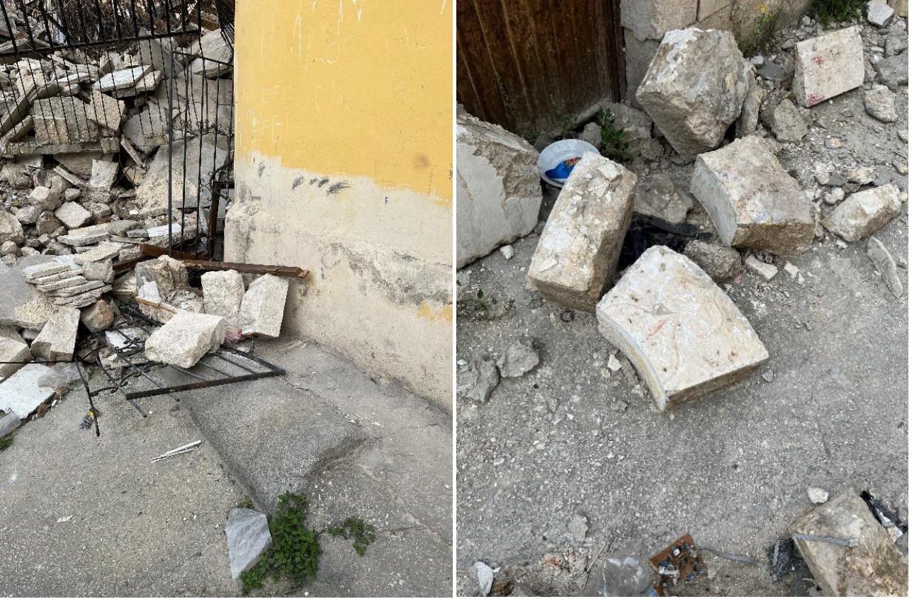
Şekil 43. Kamusal alanlarda tespit edilen devşirme malzemeler ve profilli taşlardan örnekler (ODTÜ TAÇDAM, 2023)
