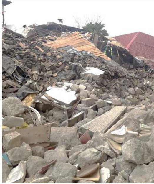
Şekil 50. Tamamen yıkılmış bir yapı örneği
